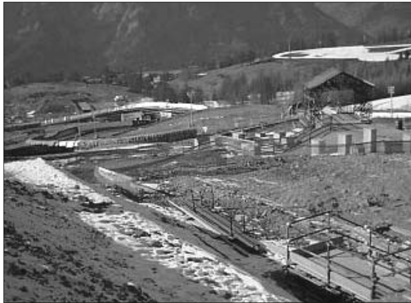
La nuova pista olimpica di Bob a Cesana Torinese in fase di completamento
